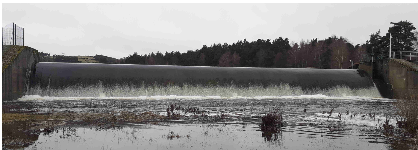
Déversoir du lac du Moulinet le 14 février 2026
